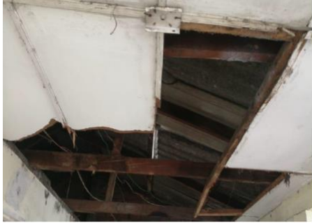
Humidité dans le plafond, entraînant une détérioration.
